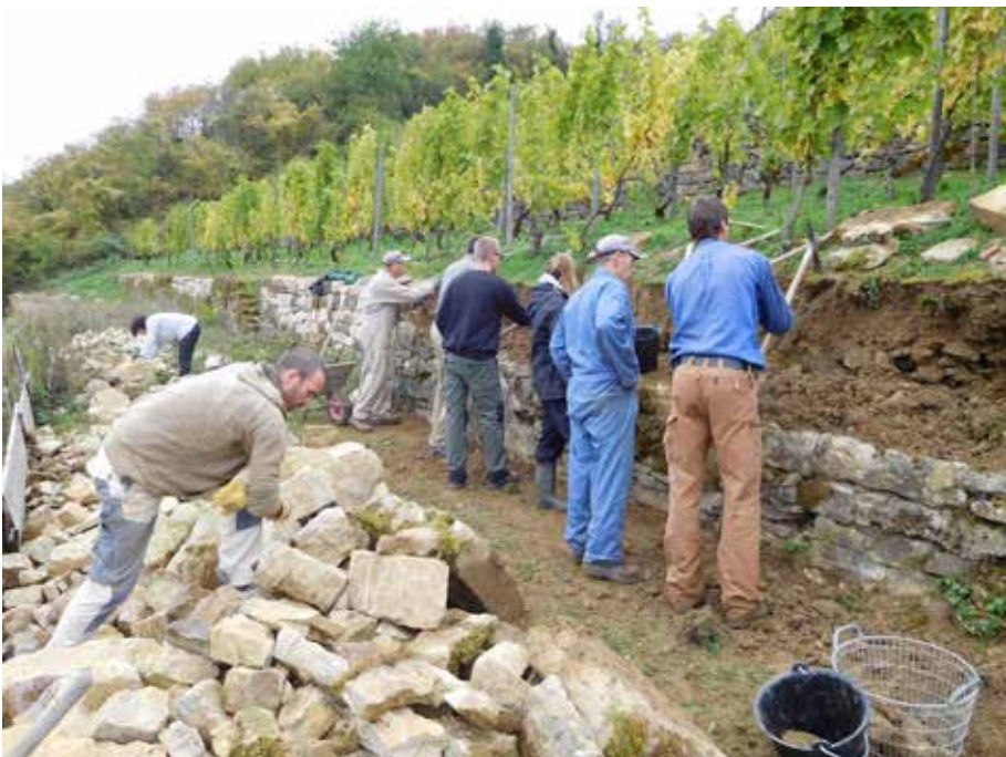
Abb. 55: Anlegen einer Trockenmauer bei Canach. Foto: Yves Kail.
