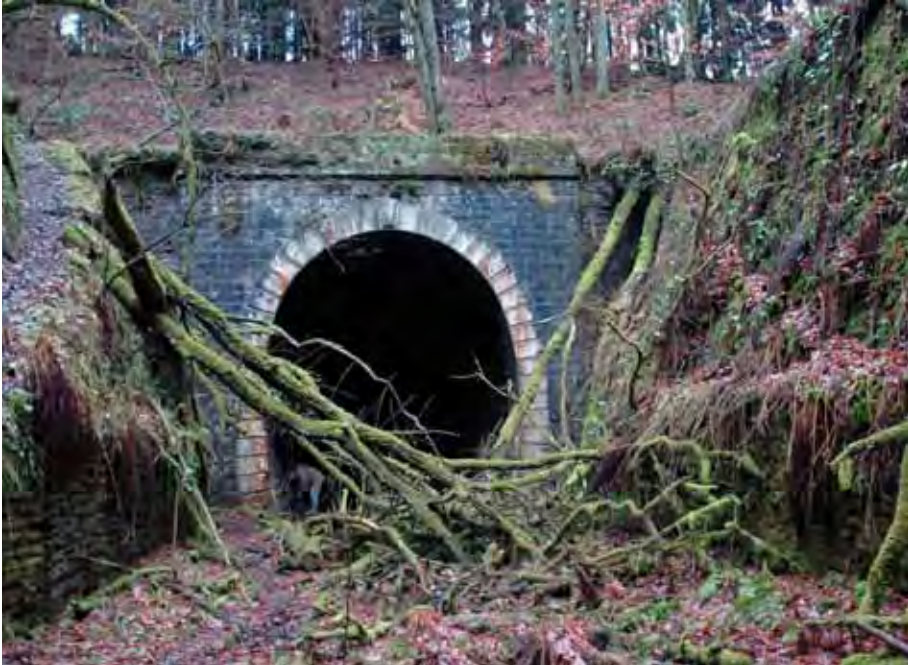
Abb. 9: Tunnel Huldange, Südportal. Foto: Harbusch.
