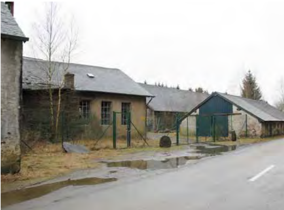
Abb. 7: Minn vun Asselbuer, Außenanlagen.
