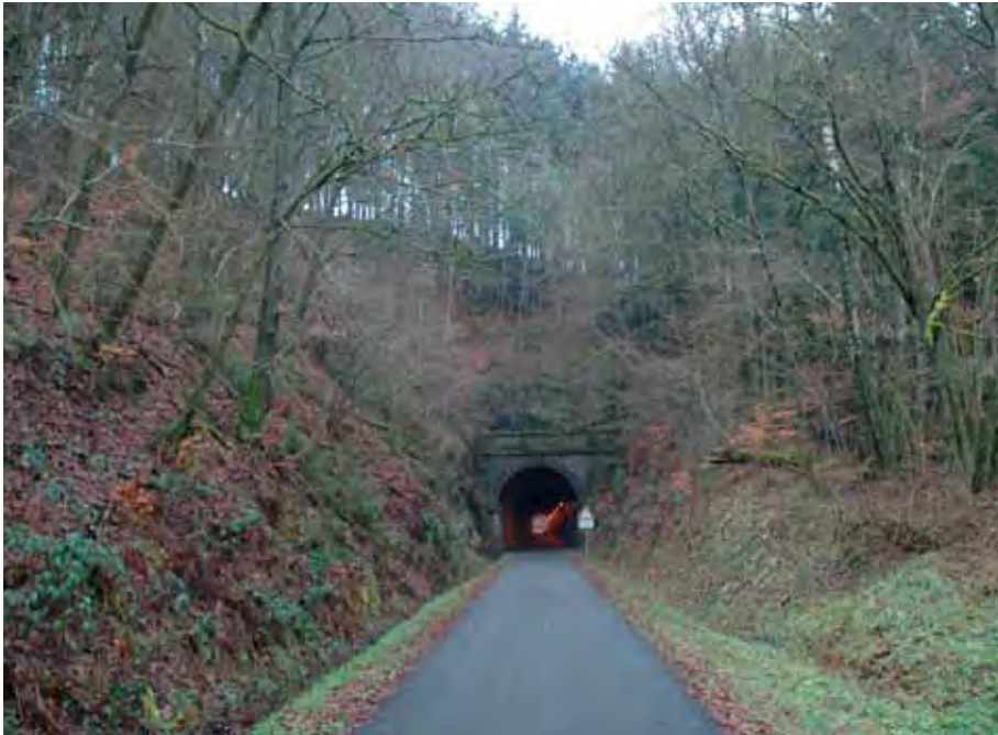
Abb. 14: Tussen-Tunnel II. Foto: Harbusch.
