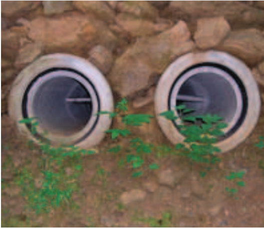
Abb. 8: Ungeeignete Verschlussmaßnahme am Stollen Laangebiërg Italien im Jahr 2010.
