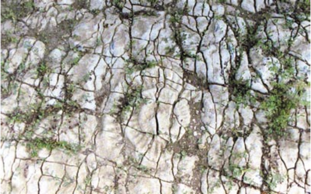
Fig. 4: Banc calcaire fissuré, se débitant en pavés.
